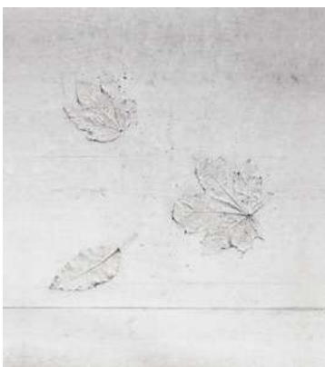
Empreintes de feuilles dans le béton du plafond de la Maison de Rive-Neuve. © Yves André.
